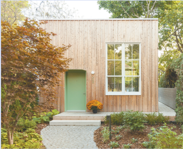
Unité d'habitation accessoire réalisé par La Shed Architecture Photos © maxime brouillet
